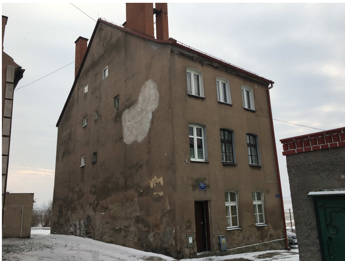
Widok elewacji bocznej.
