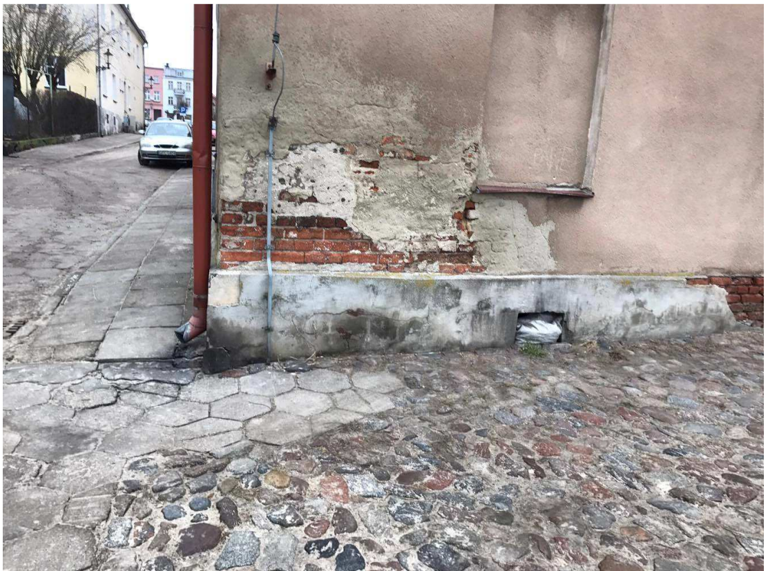
Widok okienka piwnicznego
