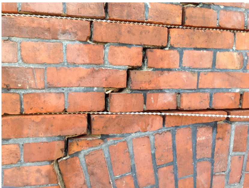
Widok zszywania pęknięć ściany z cegły
