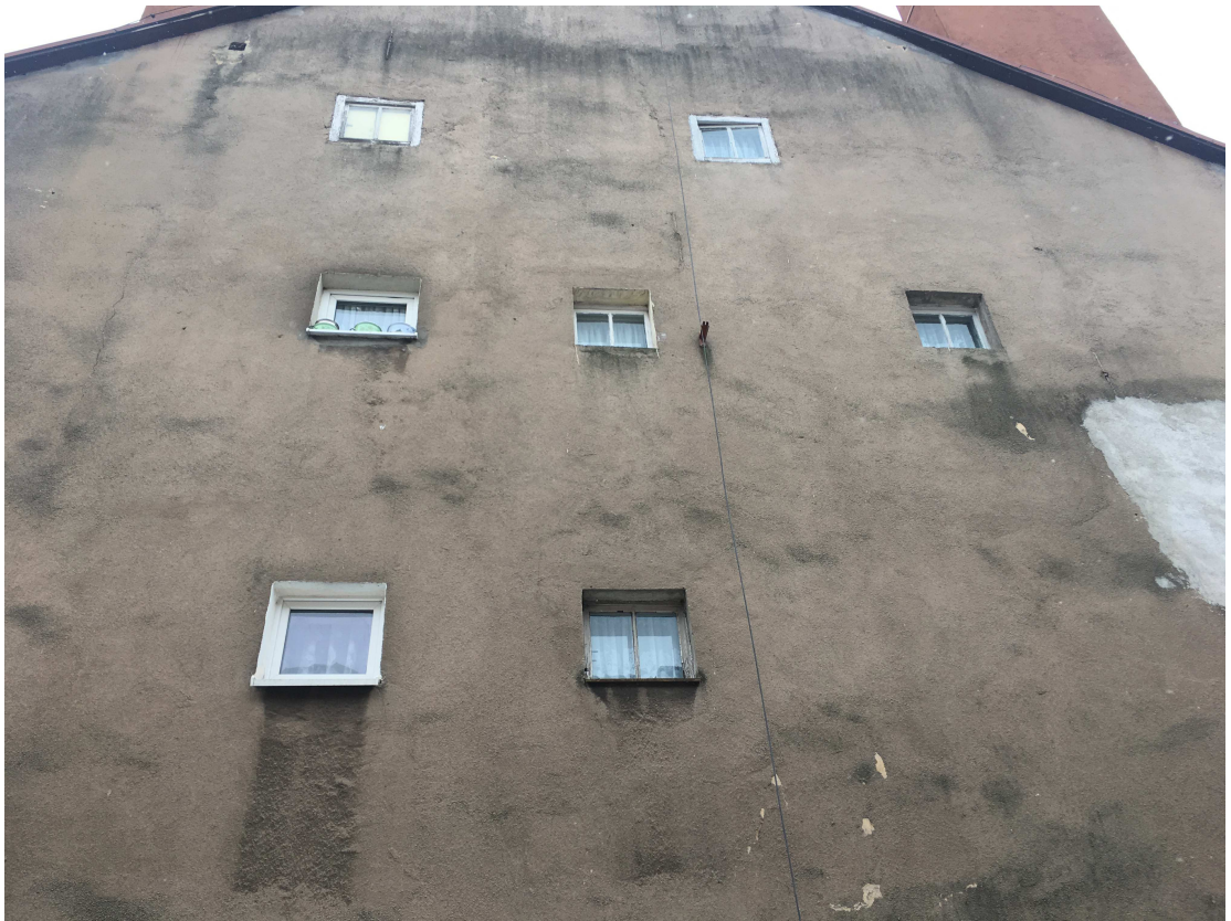
Widok okienek w ścianie bocznej
