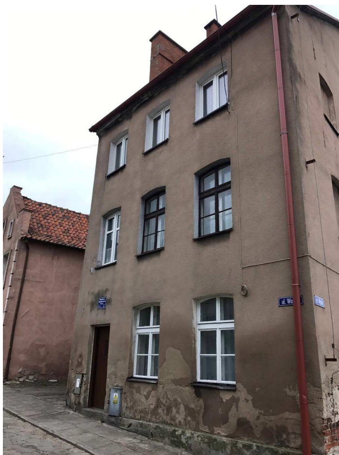
Widok elewacji frontowej budynku (od strony ul. Wodnej).
